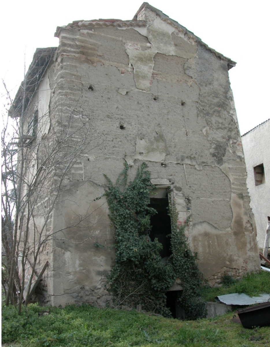
Vue de l'élévation nord.
