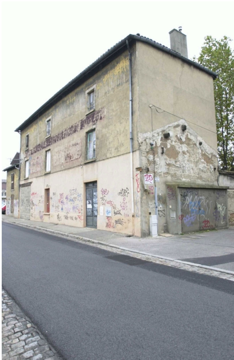
Vue générale nord, de la rue
