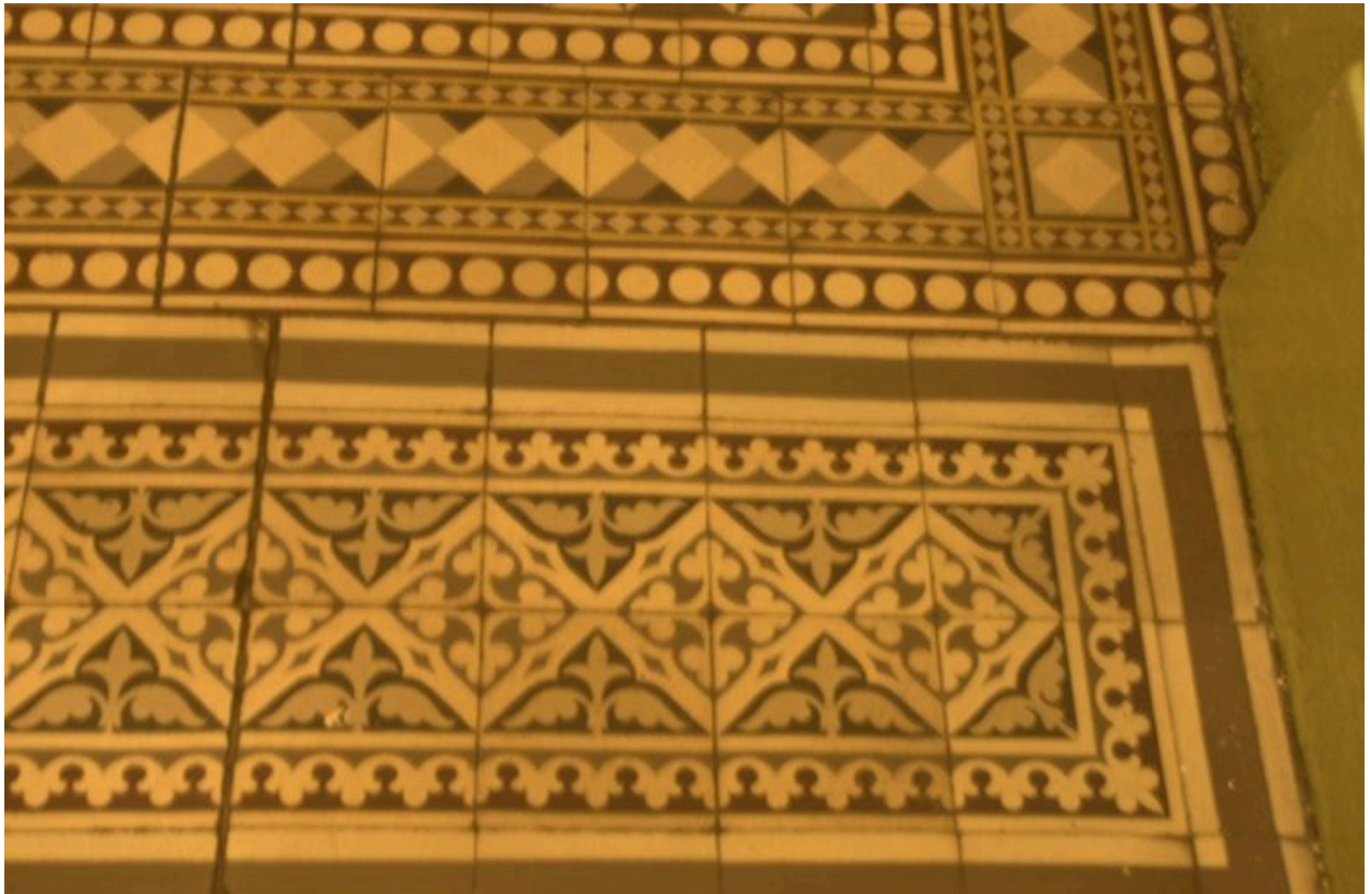
Carrelage du vestibule, détail
