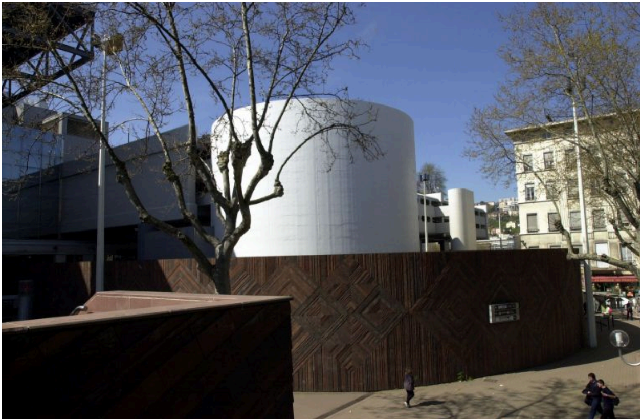
Vue d'ensemble d'une rampe à pistes hélicoïdales, pour automobiles et autobus
