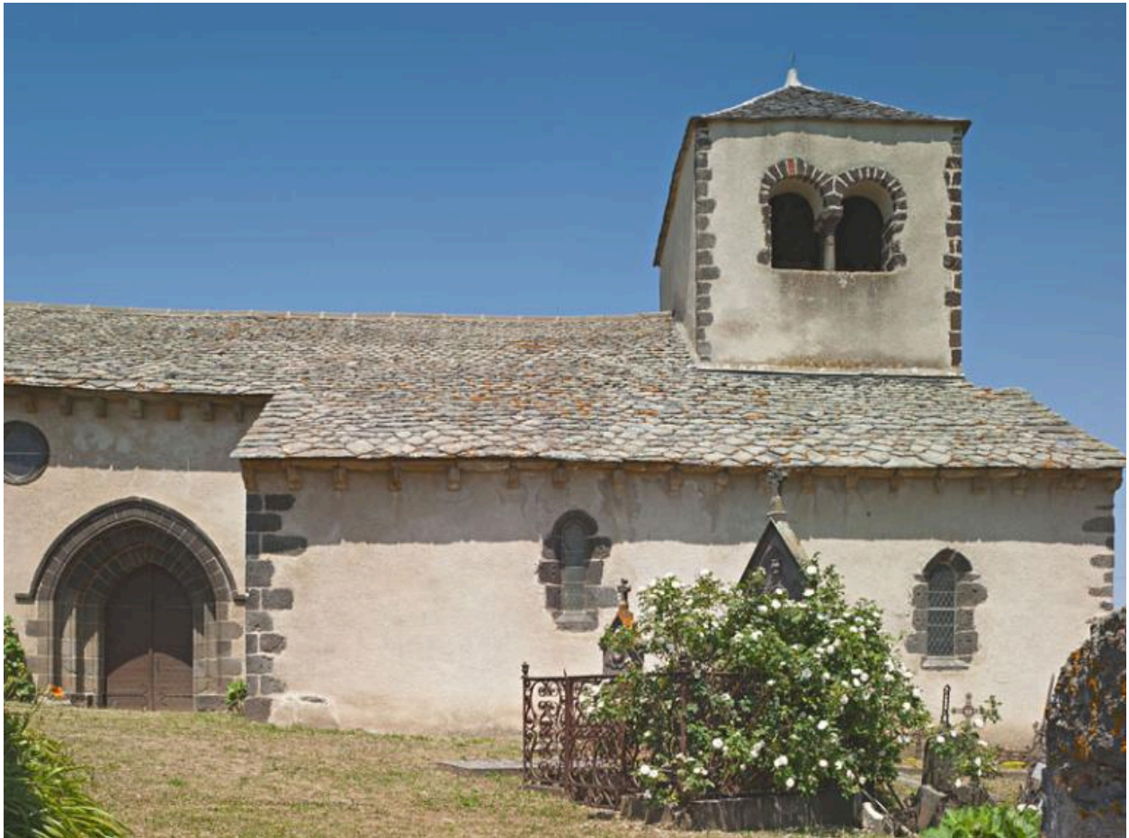
Vue générale de la façade méridionale.
