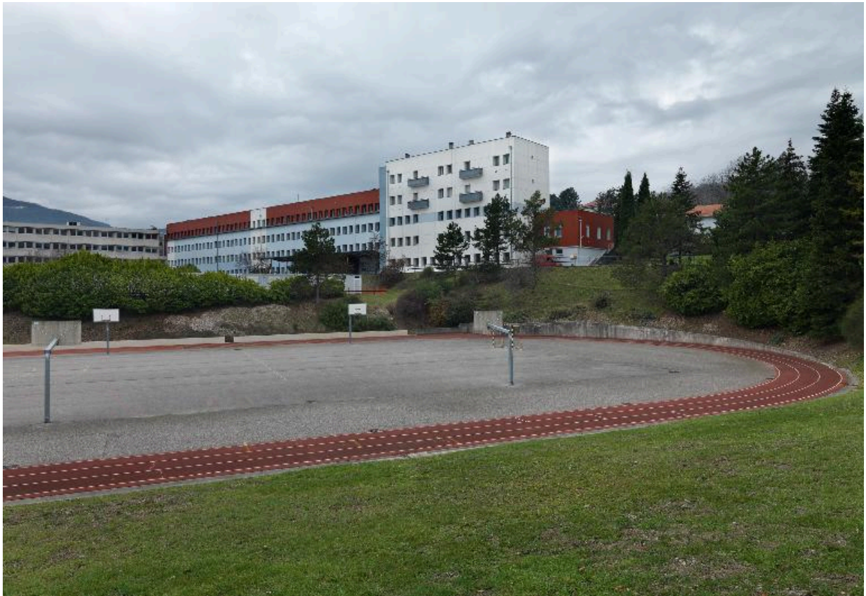
Bâtiment de l'externat : élévation sur cour, depuis le nord-est
