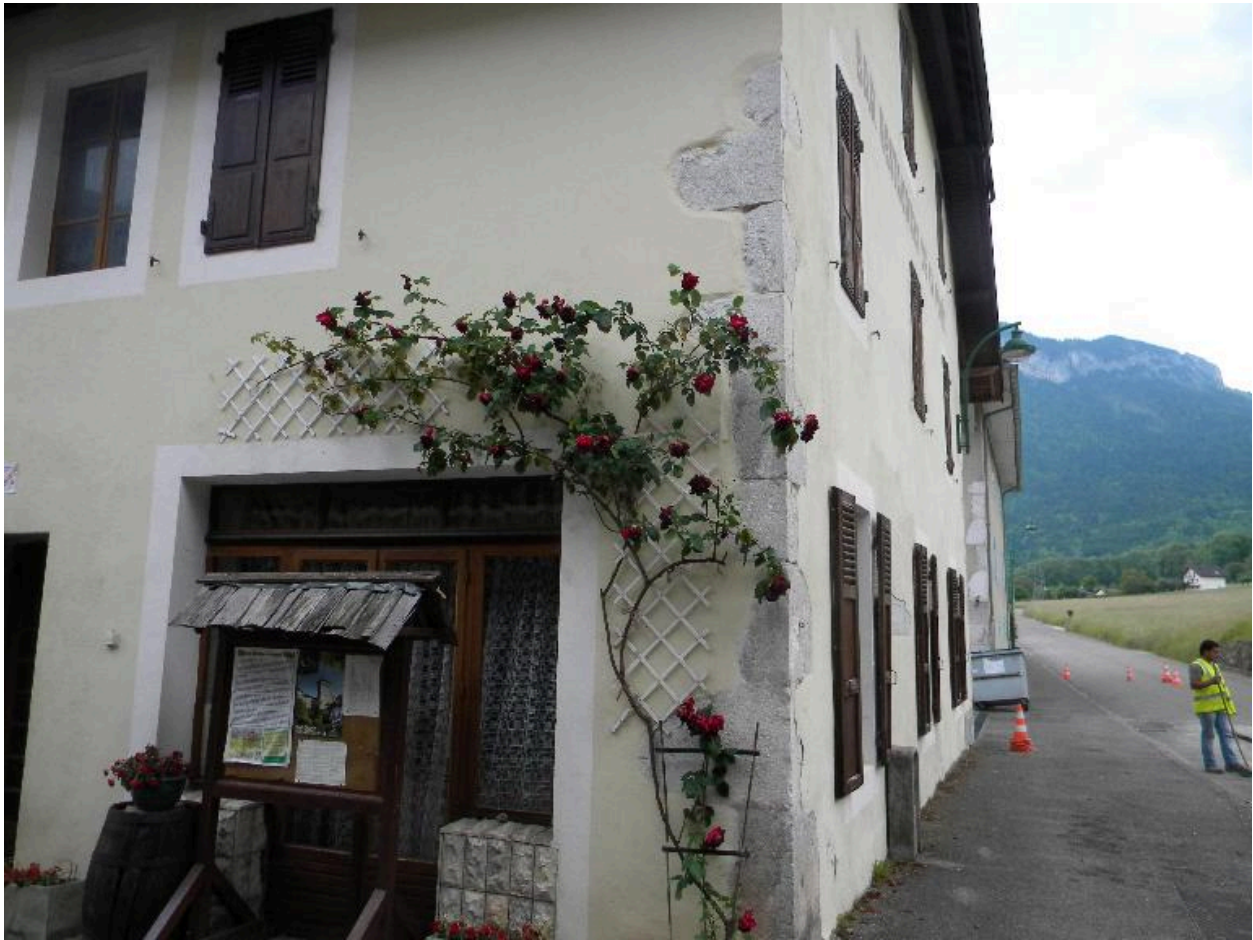
Vue de trois-quarts nord-ouest d'une ancienne auberge (2008 B3 562 bâtiment 3)
