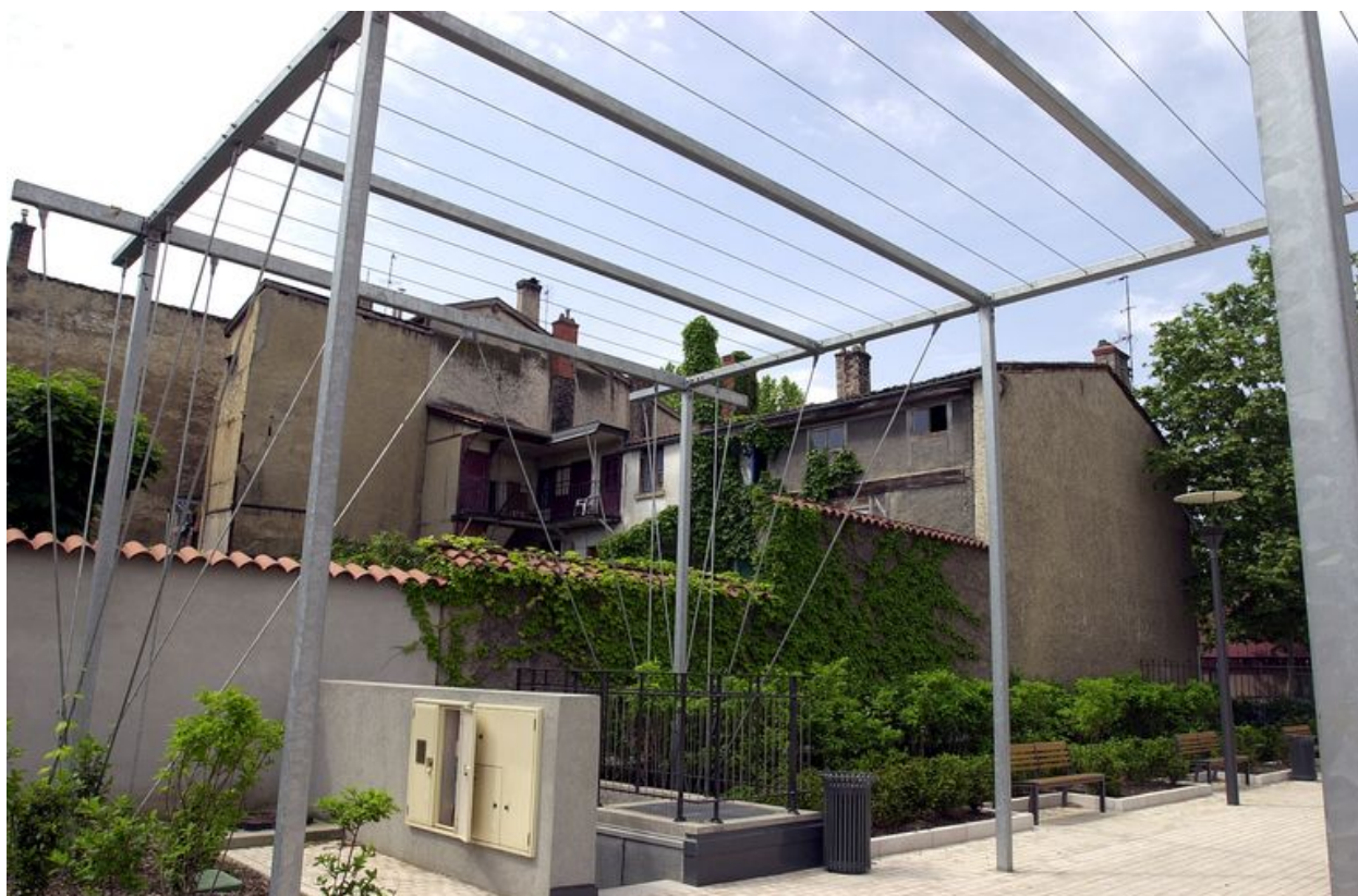
Façade postérieure vue depuis le jardin public mitoyen
