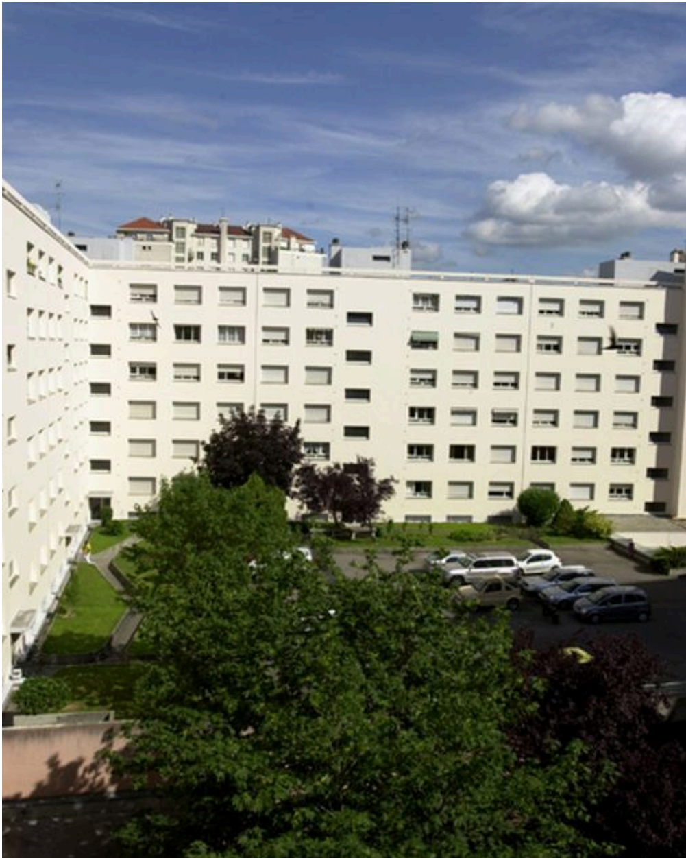
Vue du jardin, du parc de stationnement et des élévations postérieures
