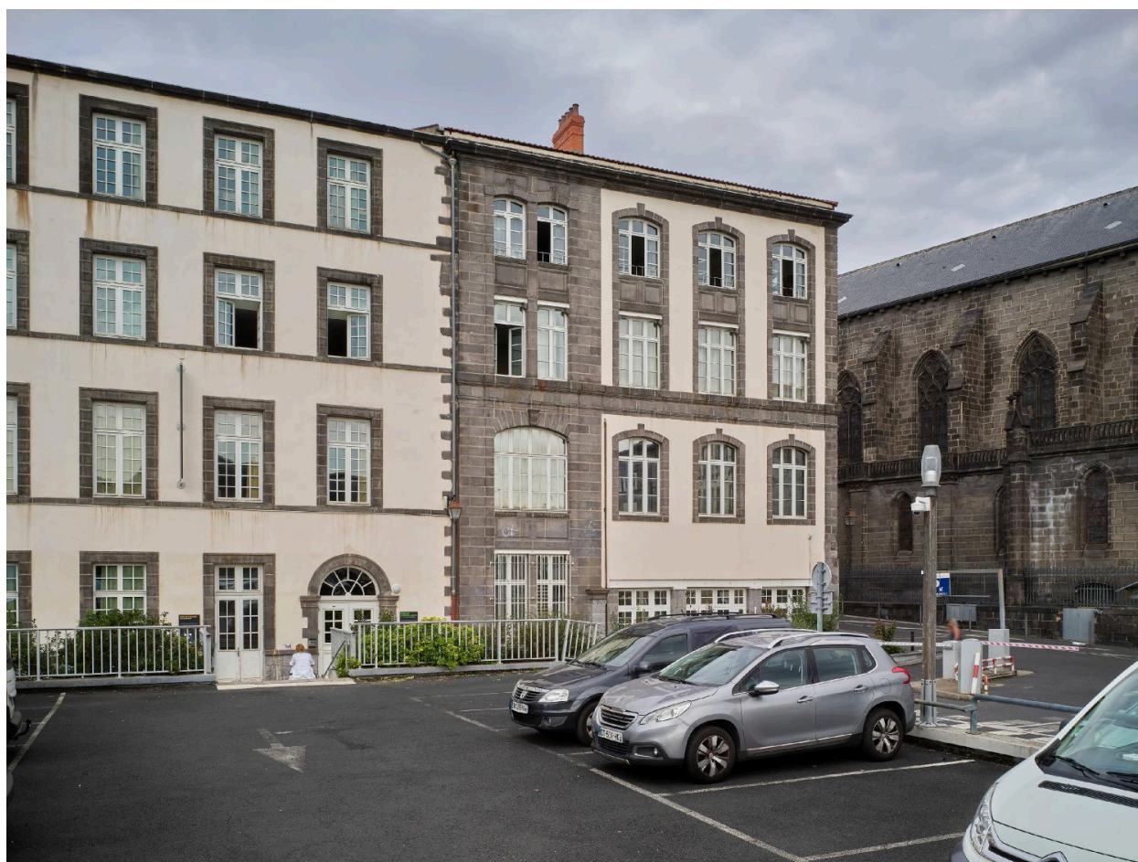
Elévation latérale est : vue partielle depuis le sud-est
