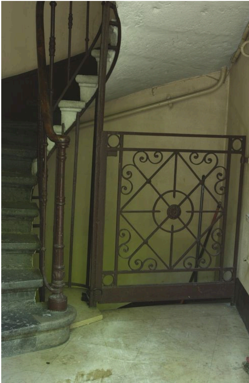
Accès à la cave : grille d'entrée
