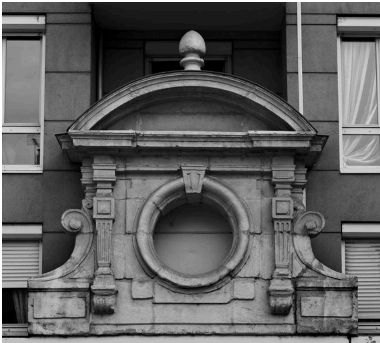
Détail du fronton remployé au-dessus du portail d'entrée
