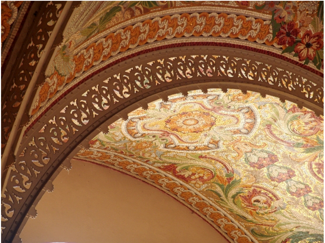
Hall nord, détail de la coupole
