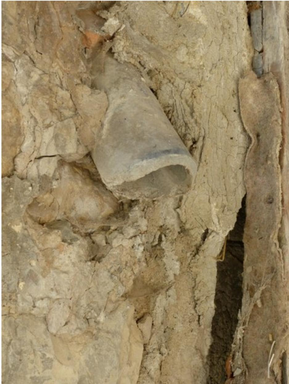
Elévation est, sous le passage couvert. Sortie de canalisation en terre cuite.
