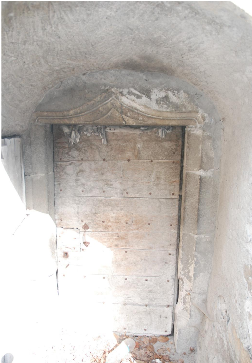
Partie sud. Maison de vigneron (2018 E2 1962). Détail de la porte de la cave avec linteau en arc infléchi.
