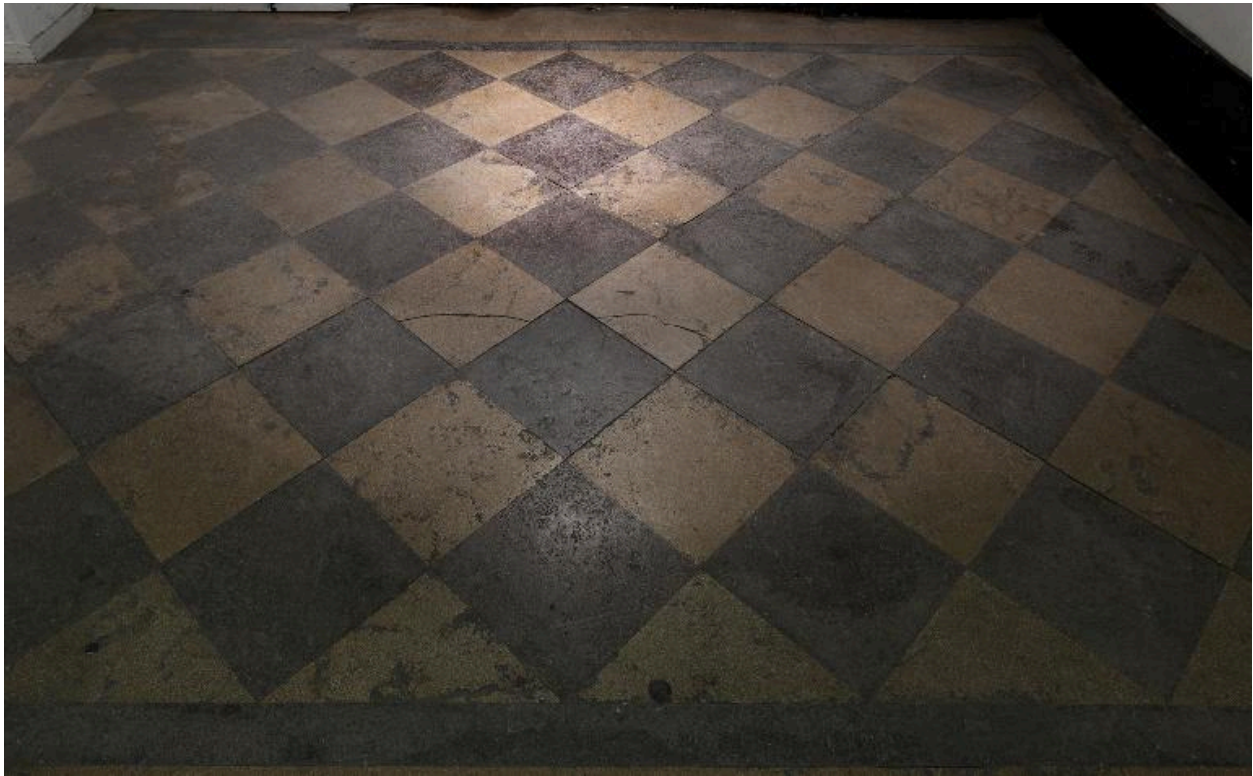
Vestibule de l'escalier E : détail du dallage
