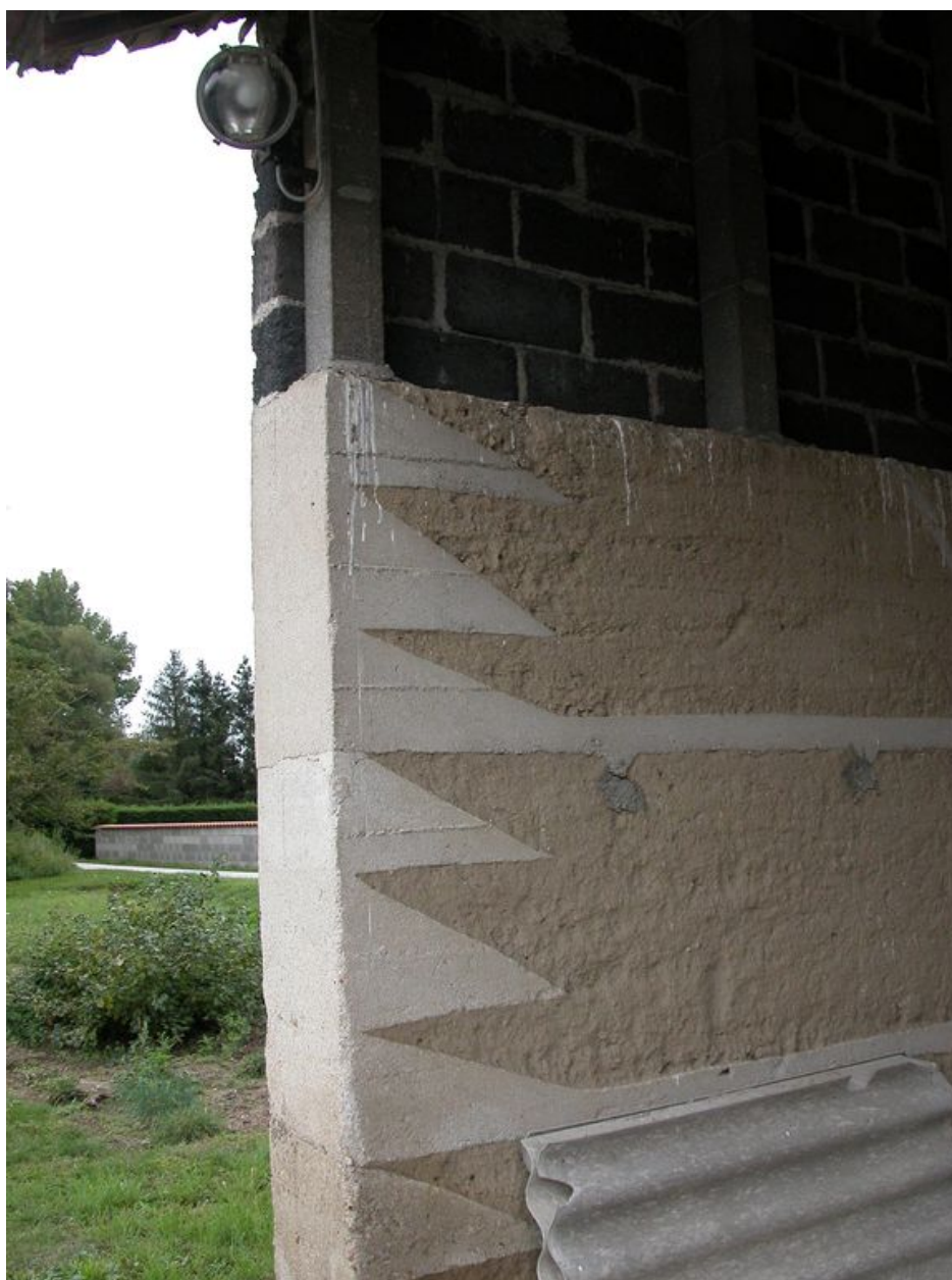
Détail du pisé de la remise.
