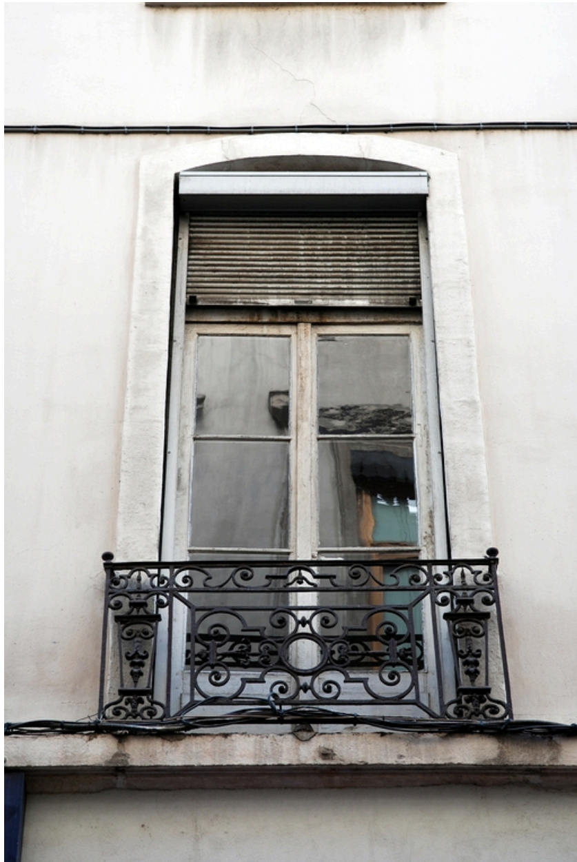
Elévation antérieure : fenêtre du premier étage carré
