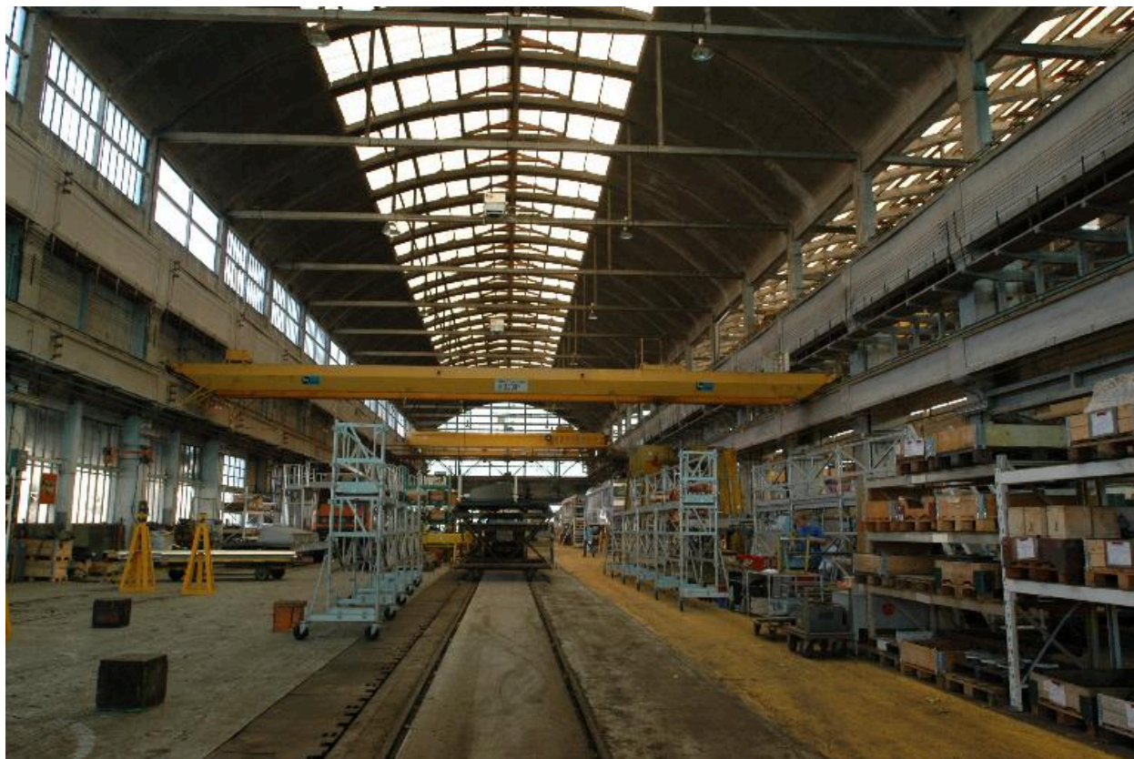
Vue intérieure de l'atelier de réparation
