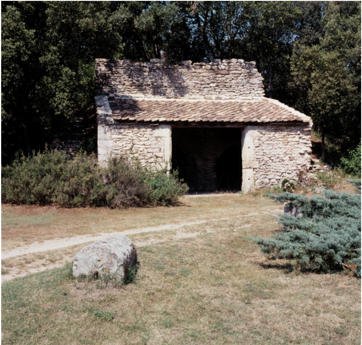
Vue extérieure du four à chaux double.
