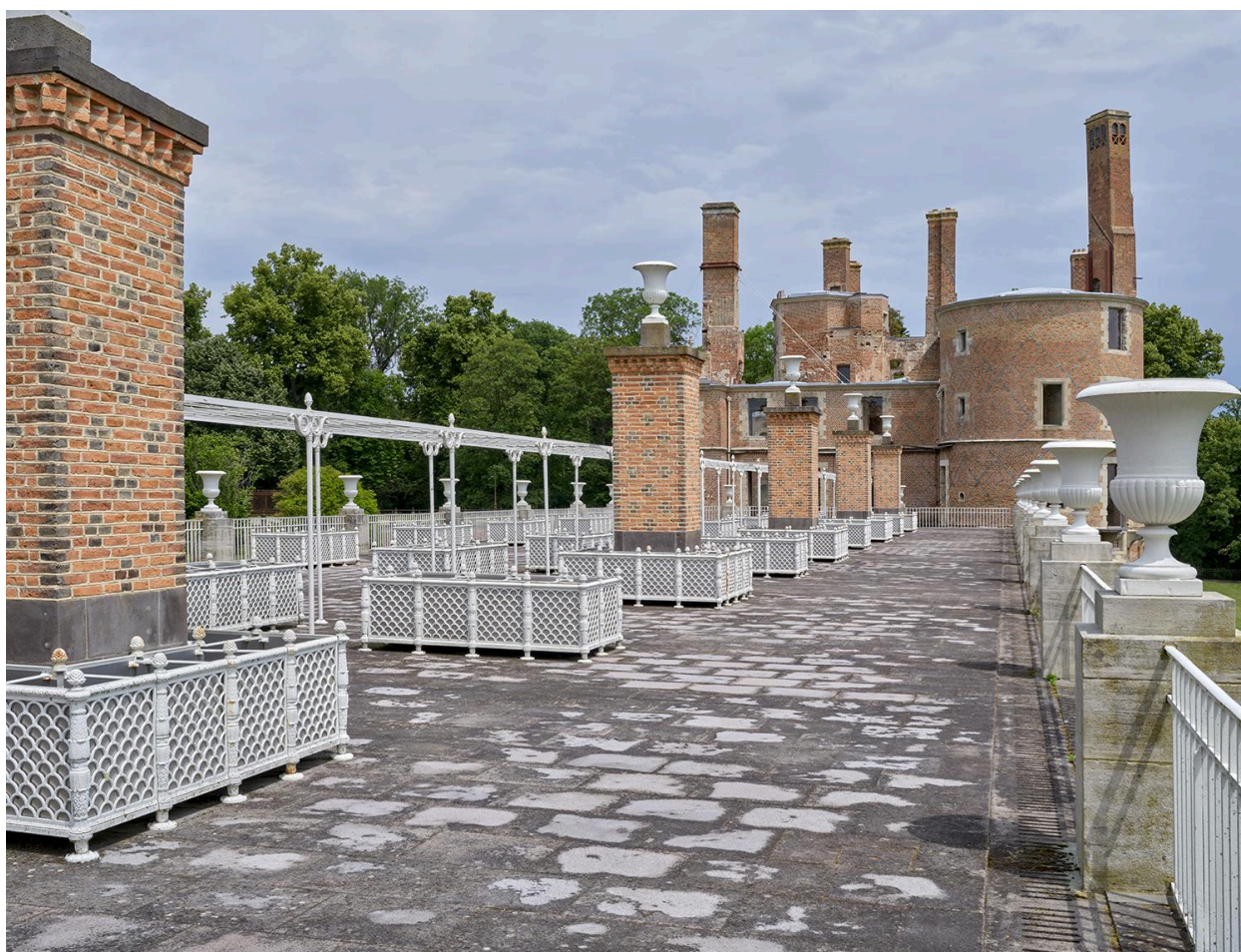
Vue de la terrasse sur l'aile des cuisines avec son mobilier
