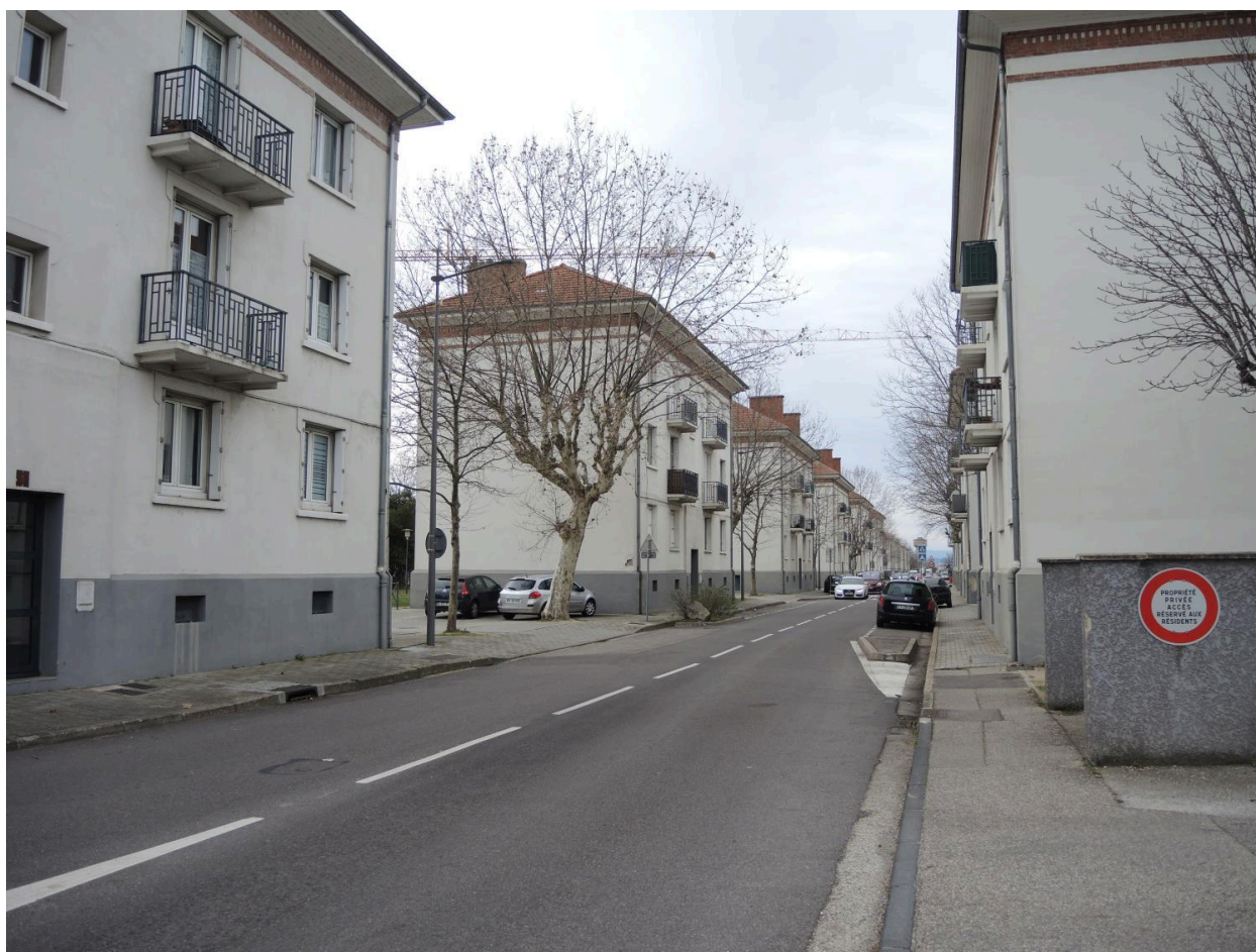
Vue d'ensemble de la cité cheminote
