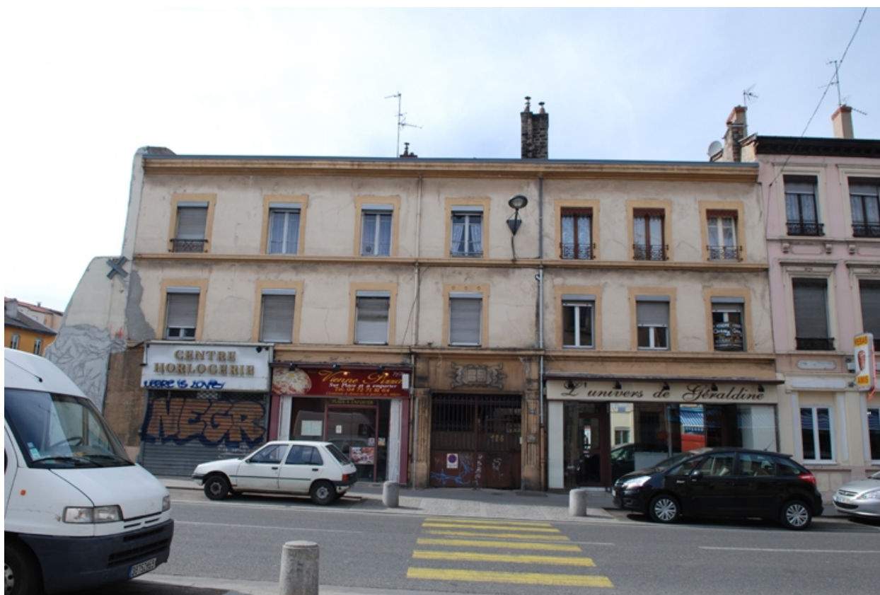
Vue du bâtiment en façade sur rue
