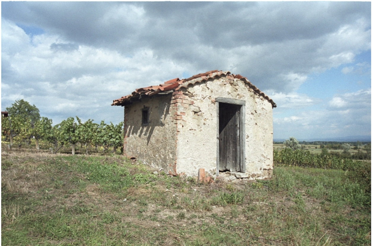
Boën, La Chaux (1986 AE 180). Loge en rez-de-chaussée de type R1a1.
