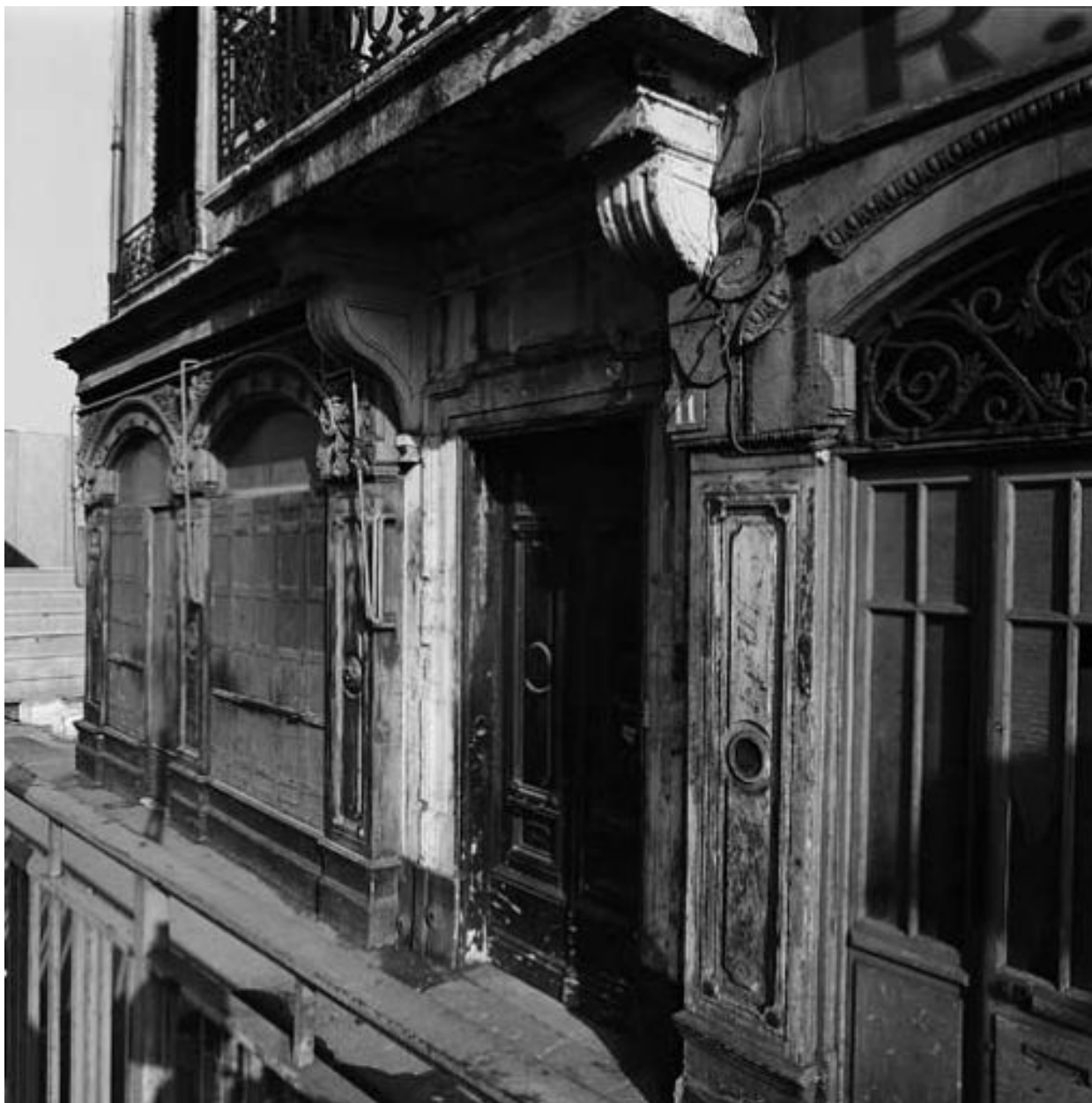
Façade principale, porte et ouvertures de boutique
