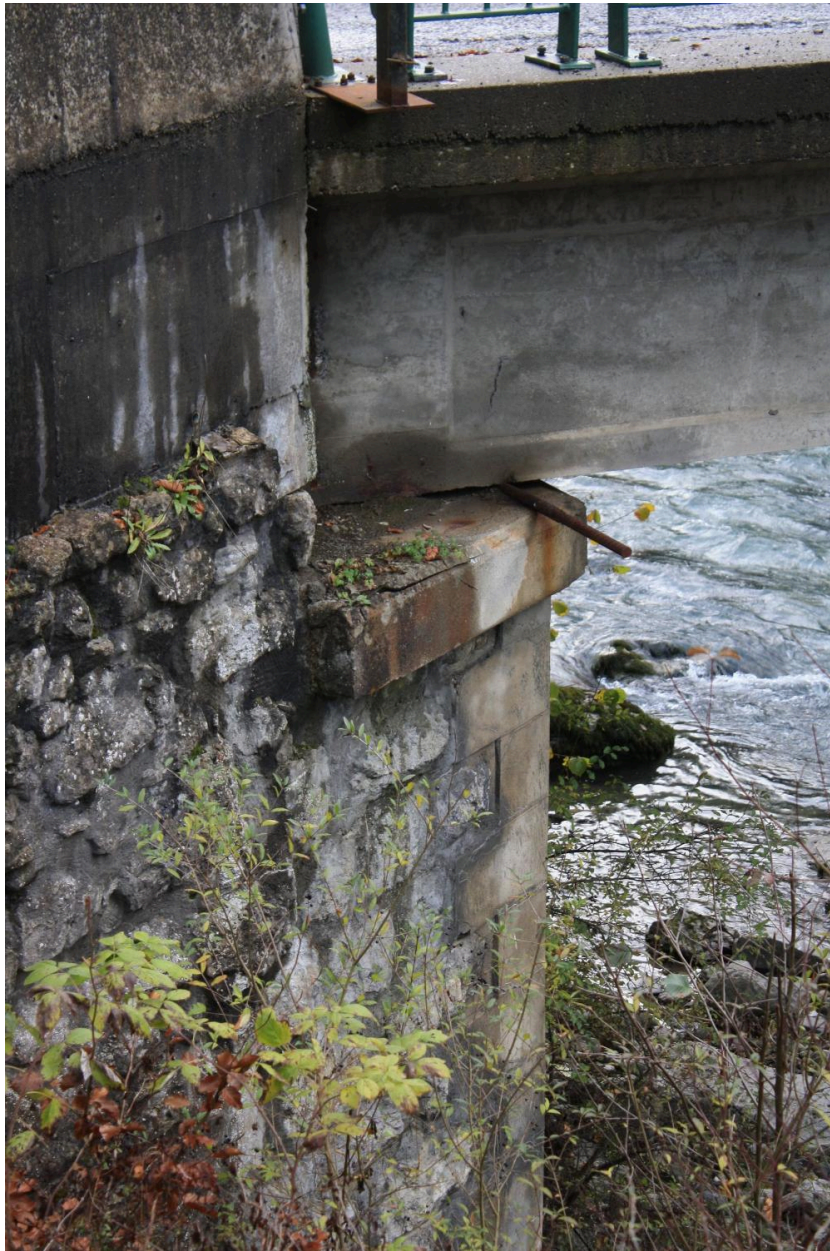
Pont de la Moussière, détail culée
