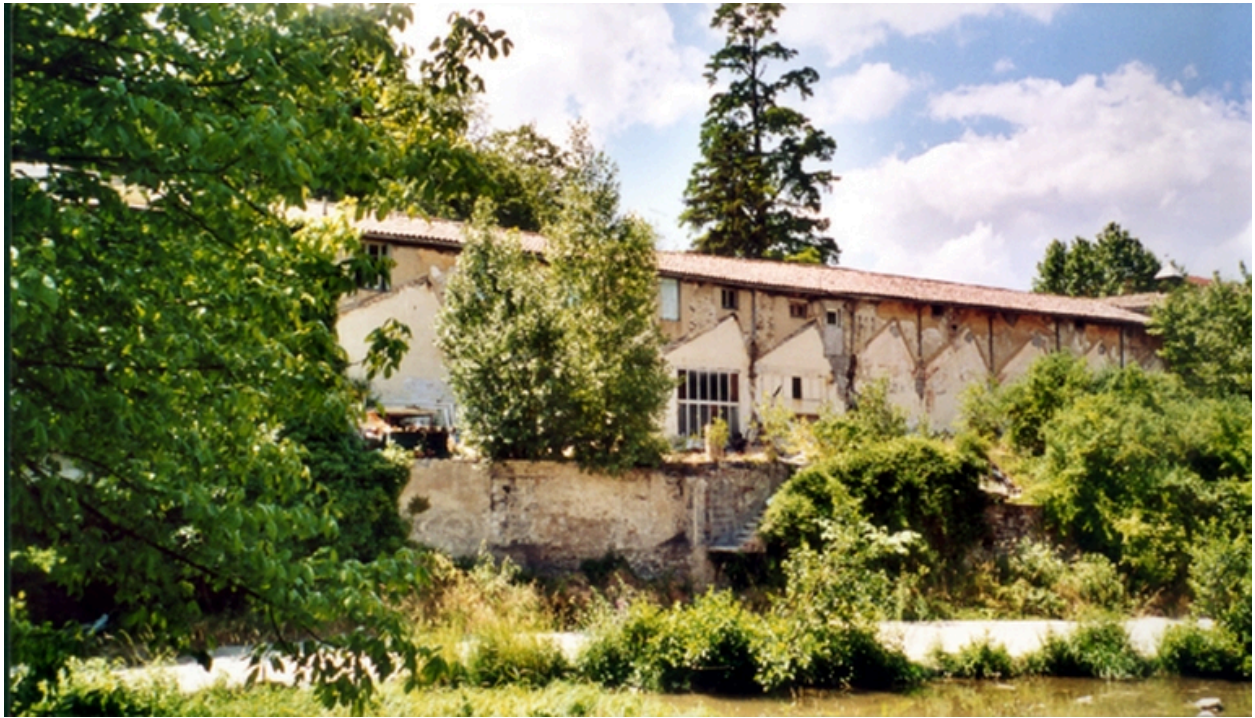
façade est, traces des anciens sheds
