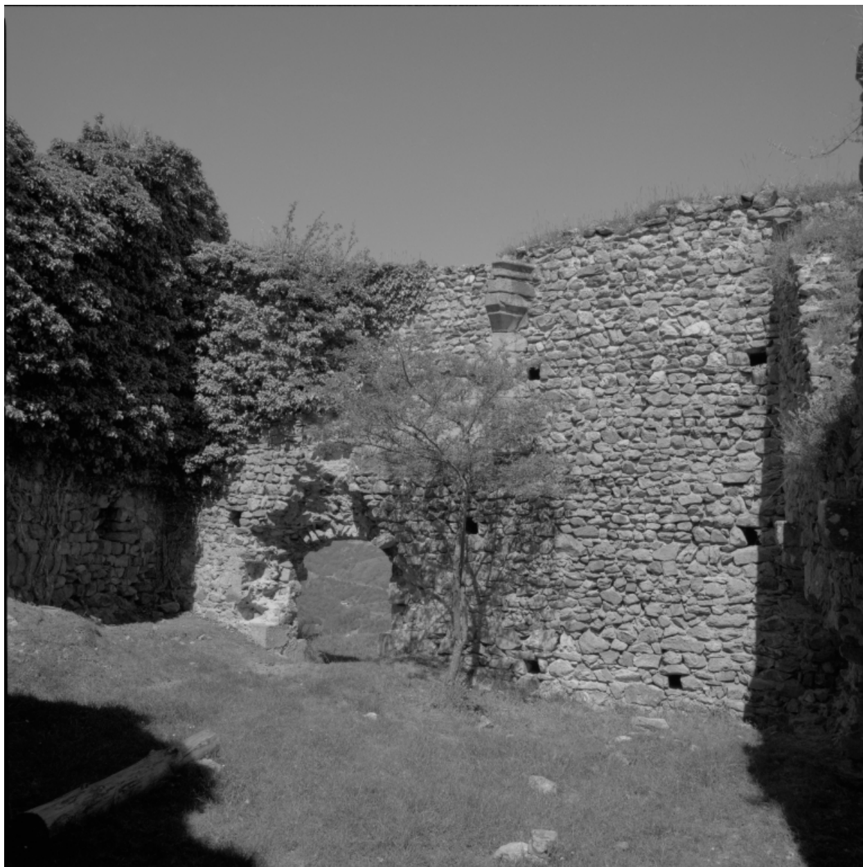
Deuxième baile, partie nord : vue intérieure du bâtiment ruiné et détail du corbeau droit de la cheminée de l'étage, de l'est.
