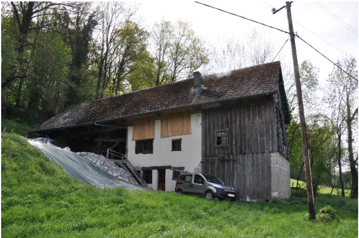
Vue générale du moulin à huile et de la scierie, vue nord
