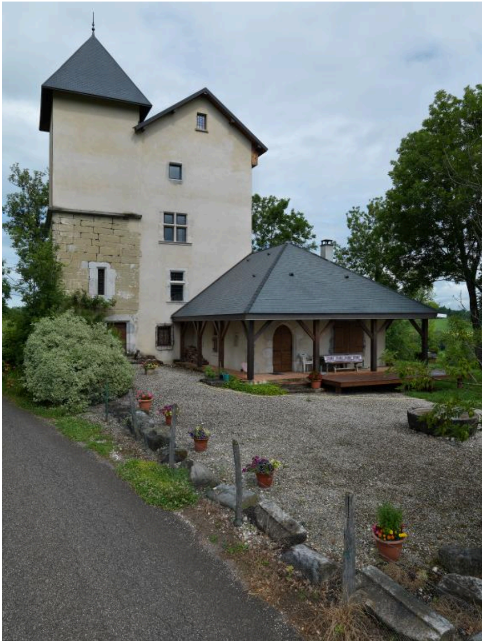
Vue d'ensemble de la façade est de la maison forte.
