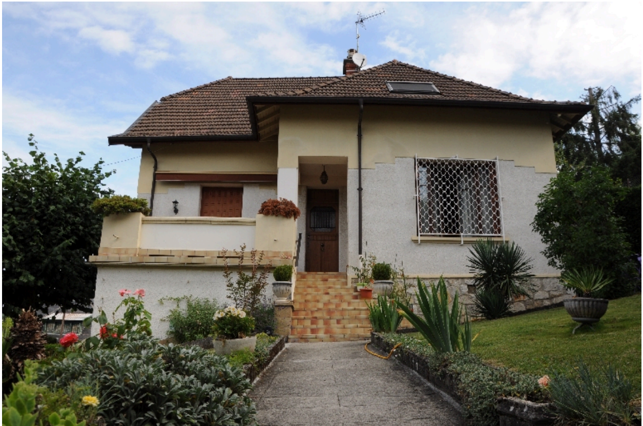
Elévation latérale sud
