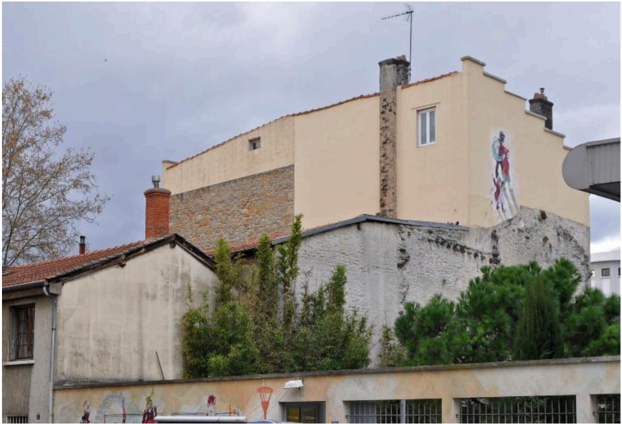
Vue latérale montrant le pignon des deux bâtiments, sur rue et sur cour
