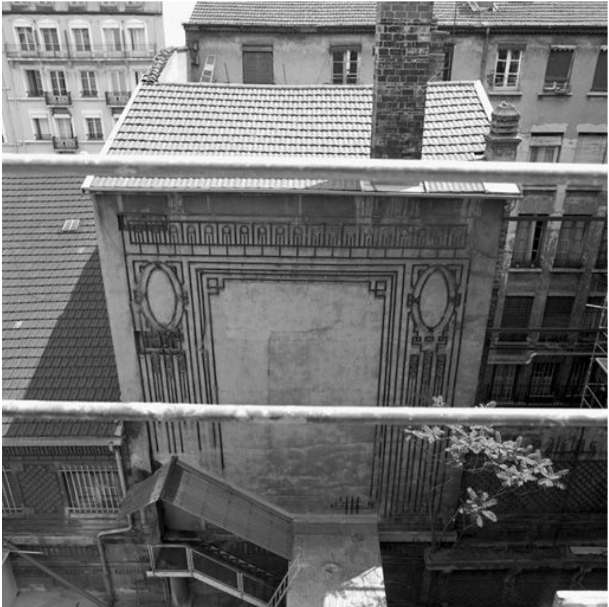
Élévation ouest sur cour et son décor pris depuis la cage d'escalier de l'hôtel Ibis
