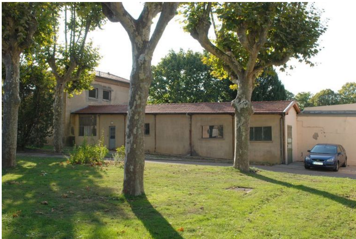
Bâtiment 333, partie ouest : galerie transformée en bâtiment vers le milieu du 20e siècle
