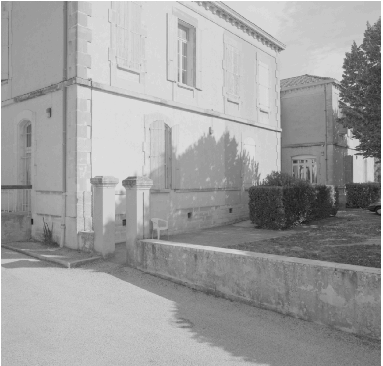
Vue de trois quarts des corps de bâtiment sur cour.
