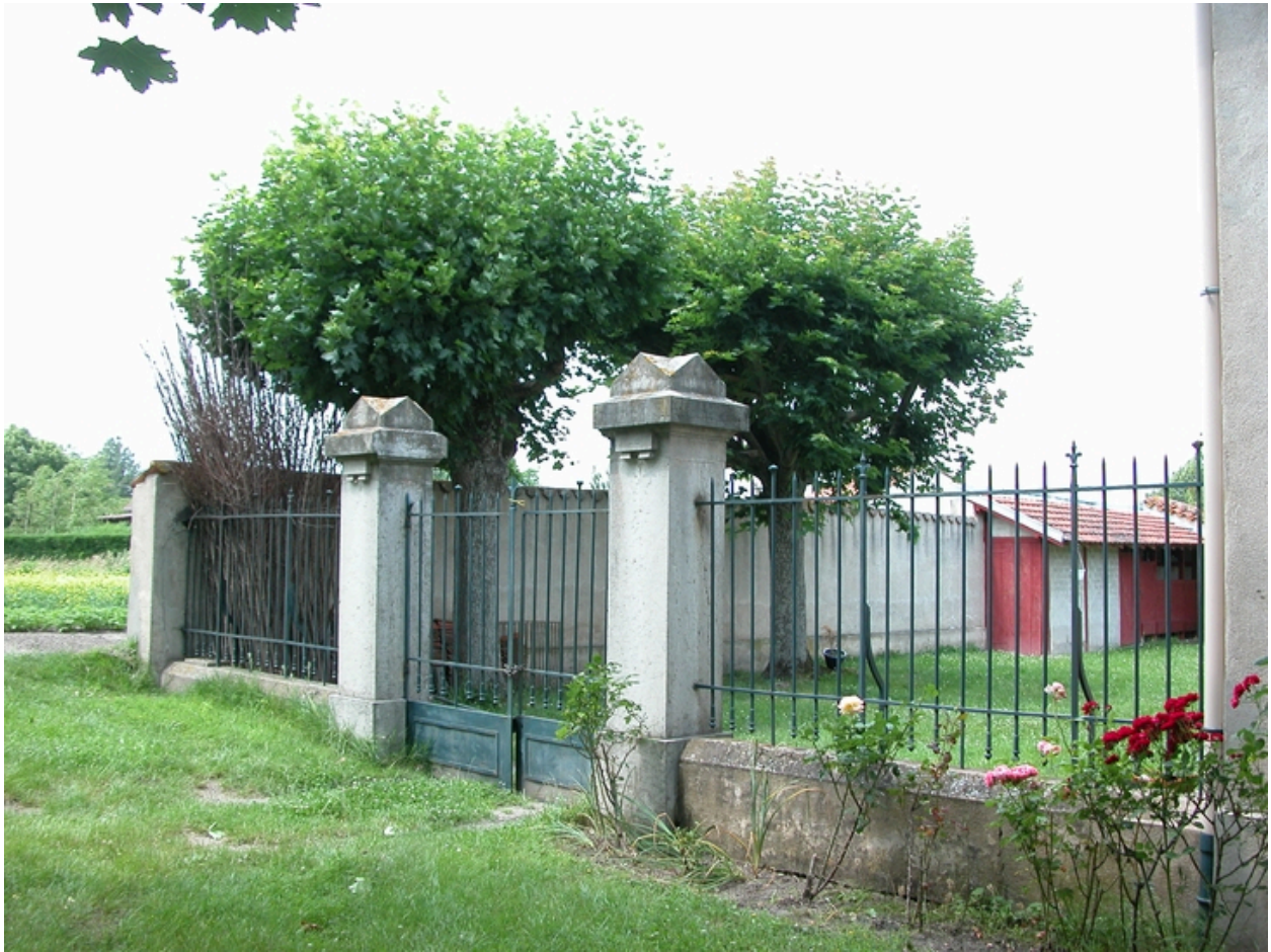
Portail du bâtiment ouest.
