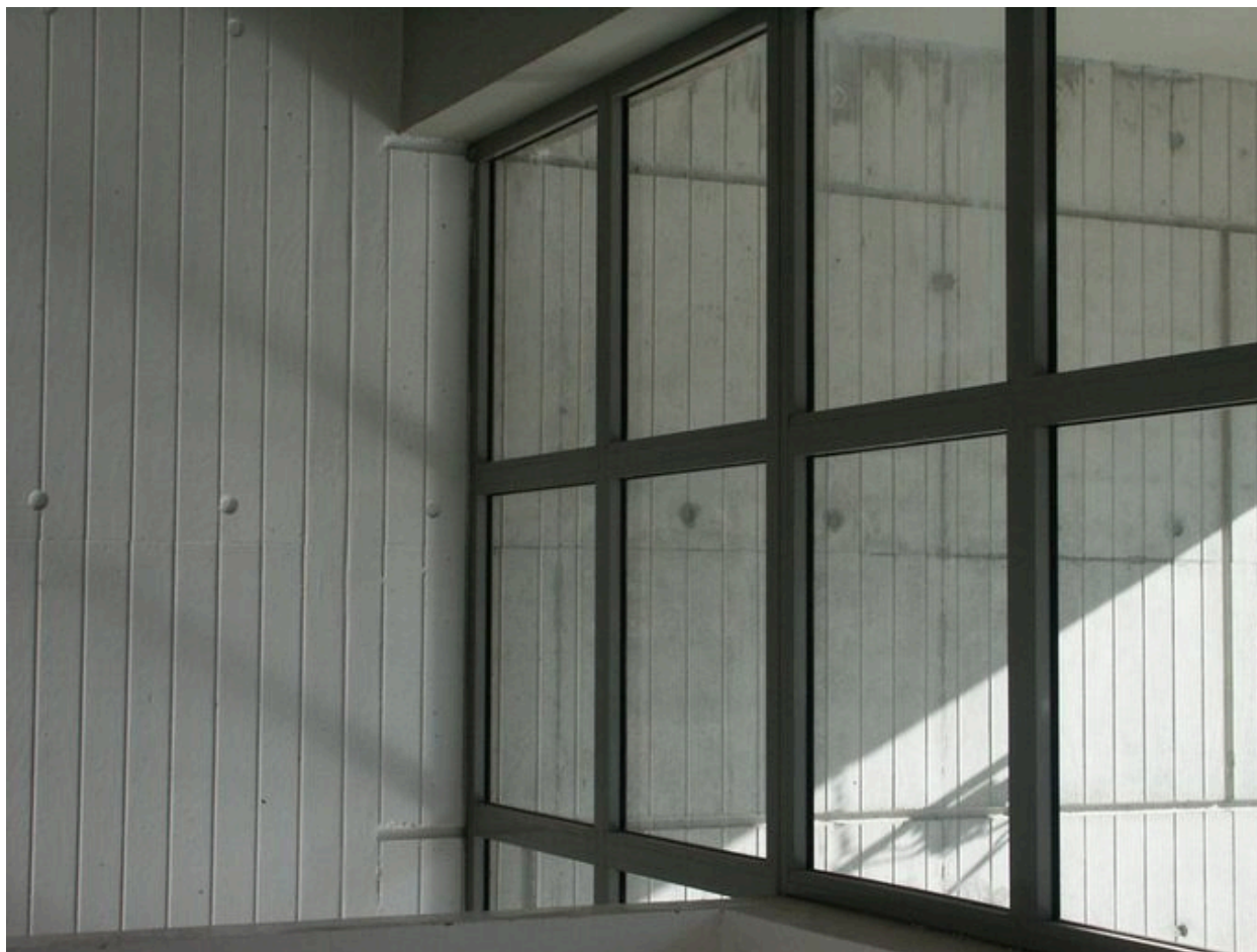
La gare inférieure. Détail de la baie de l'étage
