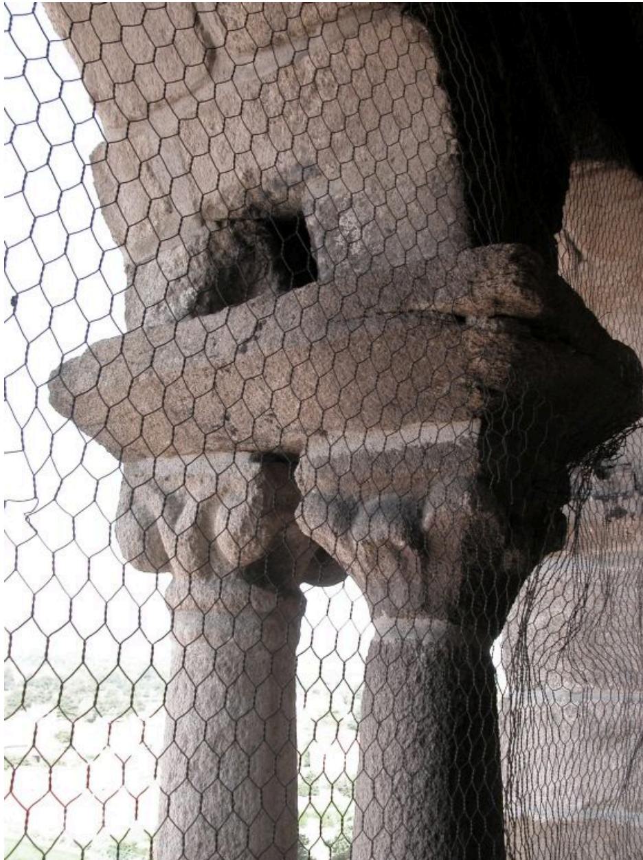
Détail des colonnettes des fenêtres géminées du niveau inférieur du clocher.
