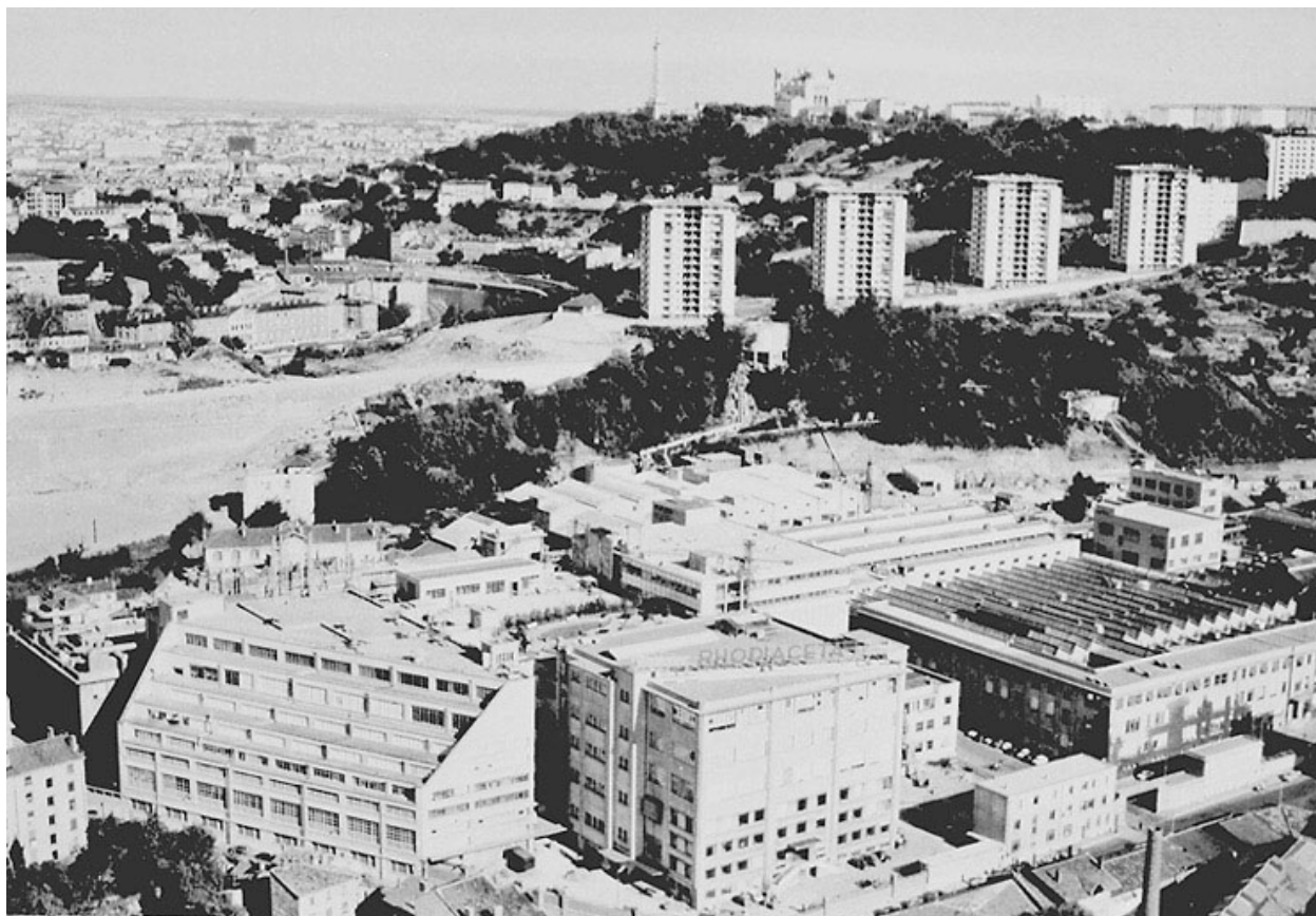
Vue générale du site en 1960
