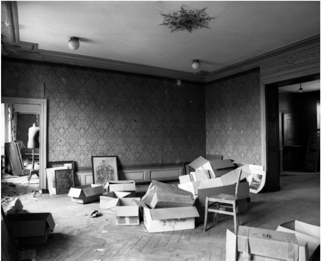
L'une des salles du 1er étage, côté sud - détruite lors des travaux de 2008 (salle +1.5 du plan schématique).
