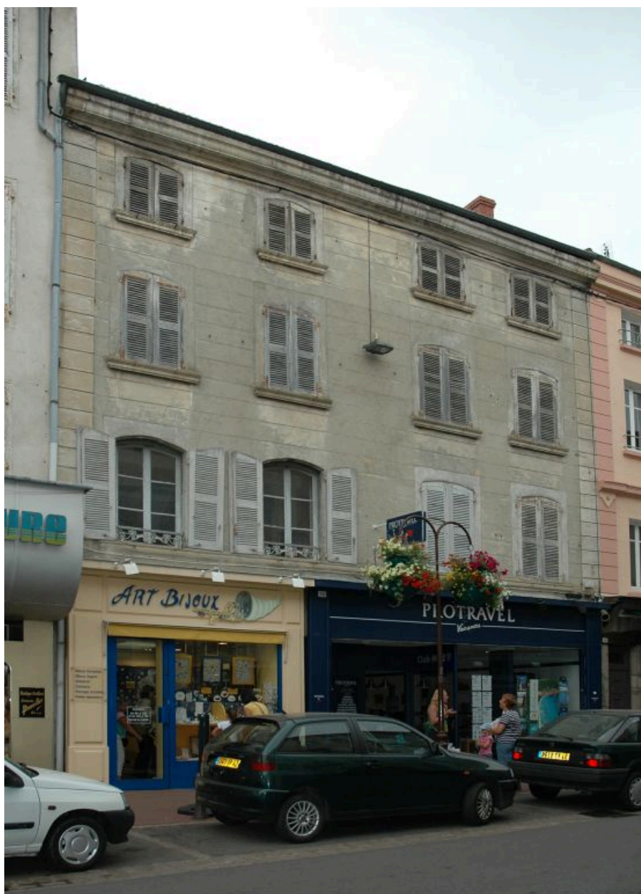
Vue générale, rue Tupinerie
