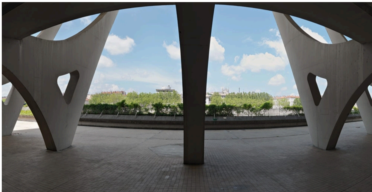
Détail du soubassement du bâtiment d'exploitation (état juin 2012).
