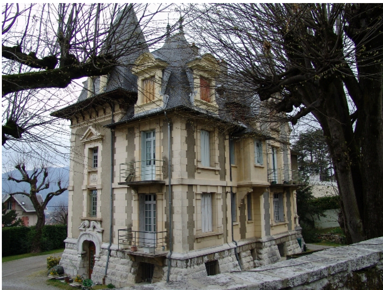
Façades postérieure et latérale droite
