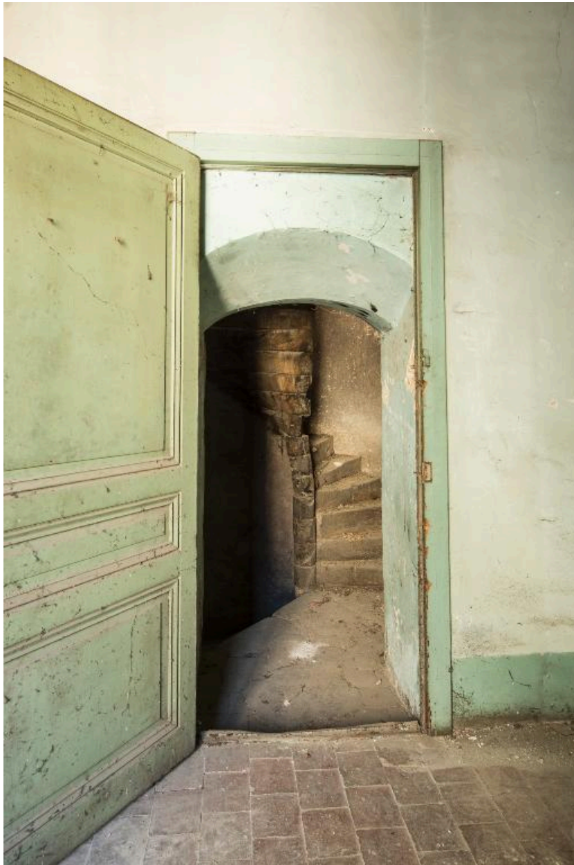
Bâtiment D. Escalier à vis menant au clocher
