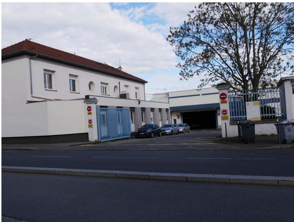
Vue des différents bâtiments du dépôt
