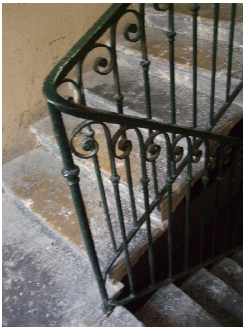
Détail escalier et rampe
