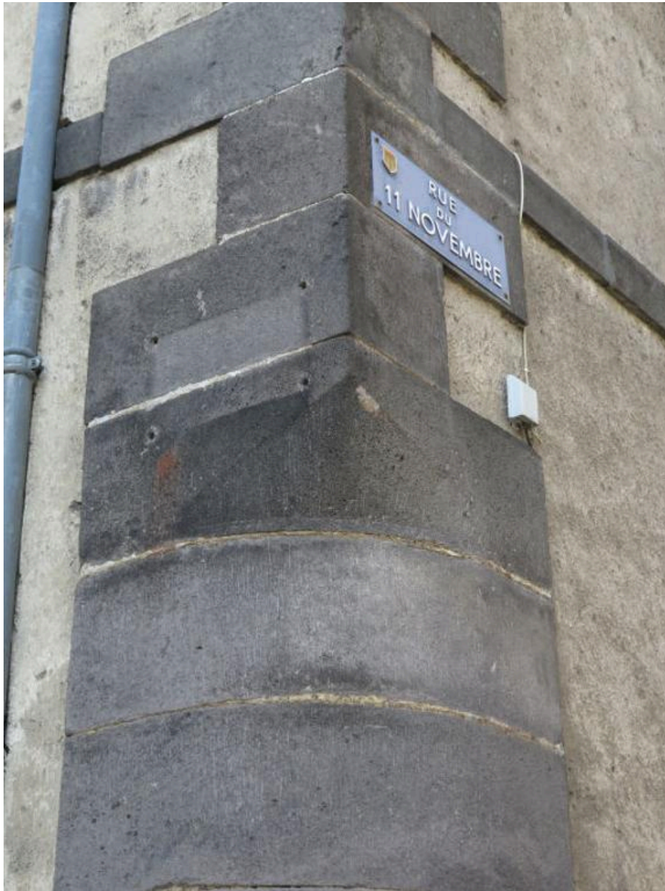
Chaine d'angle : jointure entre rez-de-chaussée et étage
