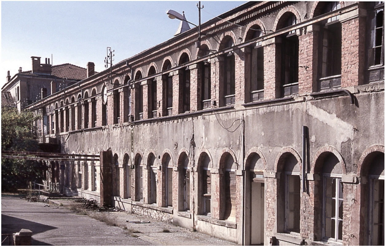
Façade est, vue nord
