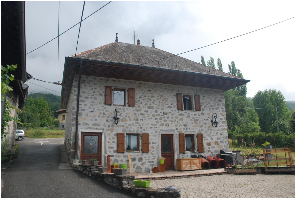
Maison, ferme (2018 E3 994). Vue sud.
