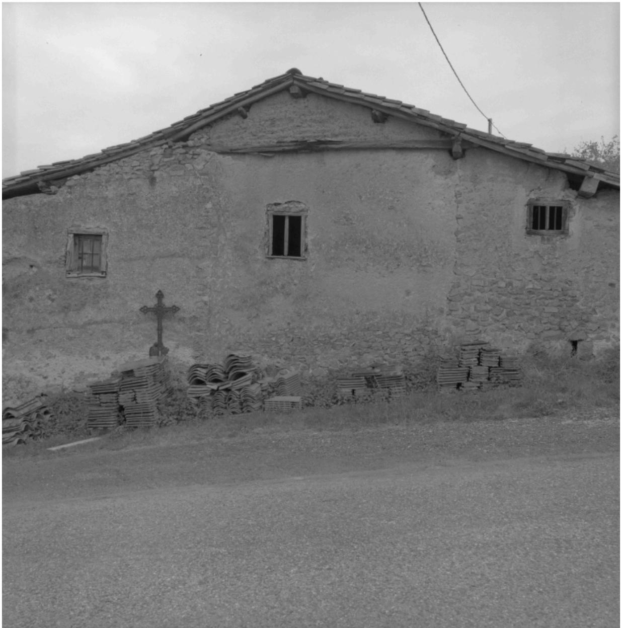
Vue extérieure du pignon de la grange-étable, système de chaînage du faîte des murs de pisé par des poutres de bois.
